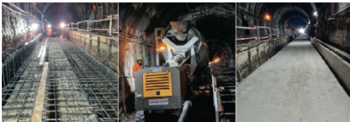
Fase in posa del ferro d'armatura - Fase di getto - Getto del nuovo arco rovescio su binario pari terminato
