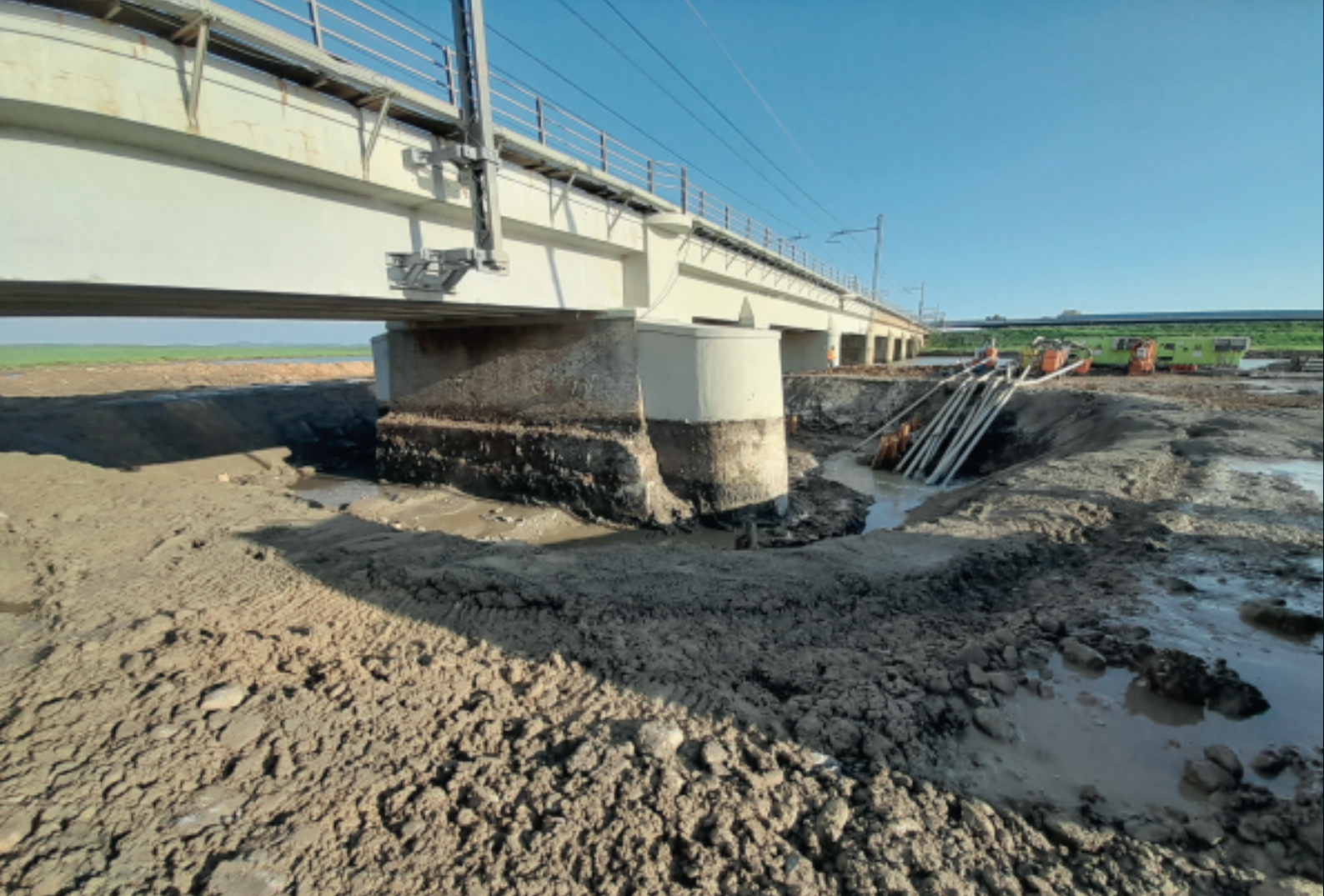
Esempio di scavo intorno alla pila
