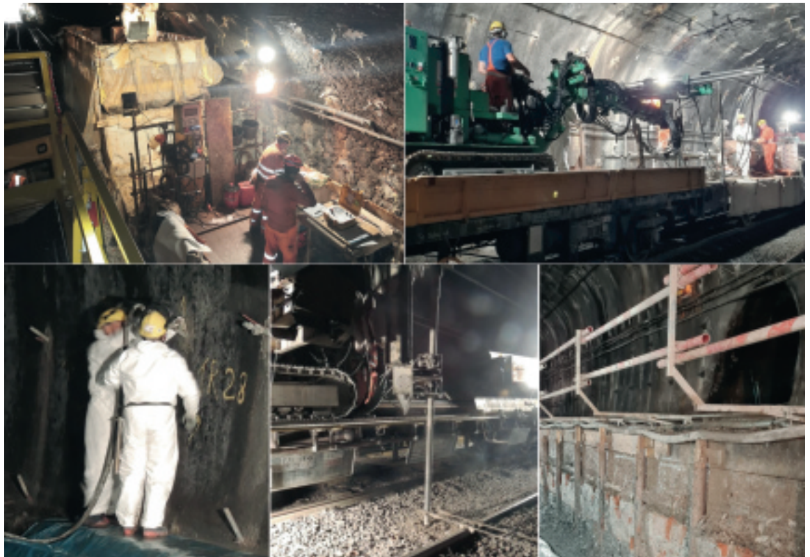
Sopra (da sinistra a destra): Iniezioni di resina poliuretana - Messa in opera di tiranti passivi Sotto: iniezioni alla base del piedritto - Targonata centrale in corso di realizzazione - Targonata centrale durante la demolizione del binario.
