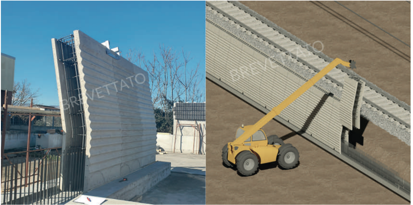
Elemento prefabbricato del sistema SQUICK in cantiere e rendering di una fase di posa
