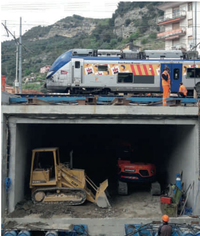
Sottopasso Ferroviario RFI Ventimiglia, tecnica "monolite a spinta" col mantenimento della circolazione ferroviaria.
