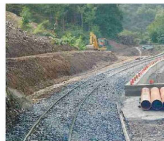
Opere ferroviarie Sono 400 i cantieri attivati grazie ai fondi del Pnrr
